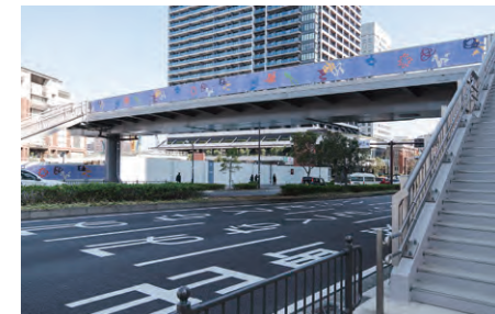
北仲クロスデッキ(歩道橋) 撮影: 大野隆介
