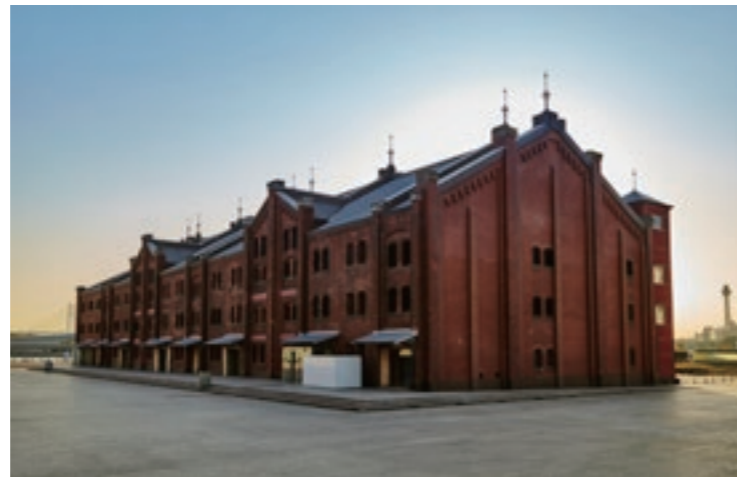
横浜赤レンガ倉庫1号館外観
