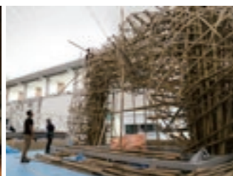
展示設営風景 Photo: KATO Ken
